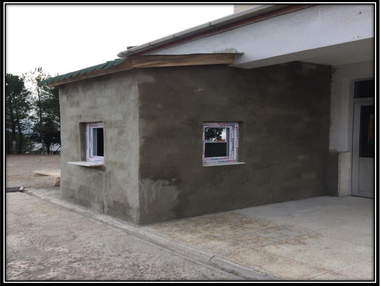
Ek 7 : Arka bahçe çocuk parkı yapımı ve okul giriři güvenlik kulübesi yapımı
